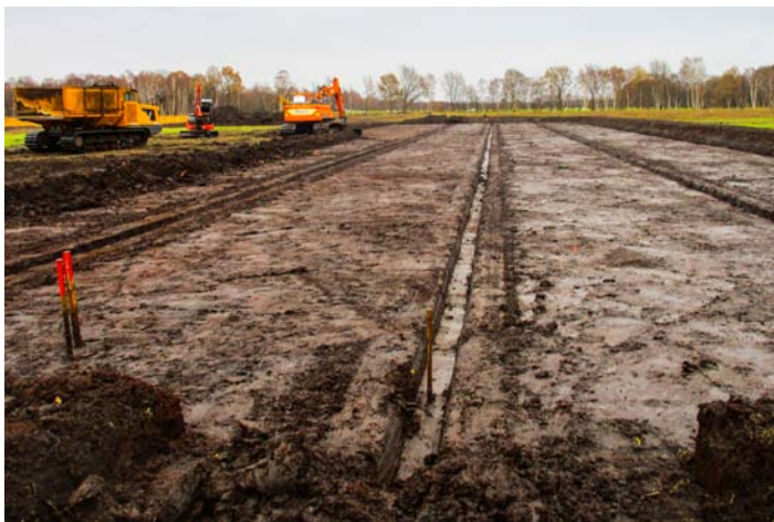
Voraussetzung für die Anlage der Torfmoosfarm: Zentimetergenau müssen der Oberboden abgetragen und die Bewässerungsgruppen ausgehoben werden.
